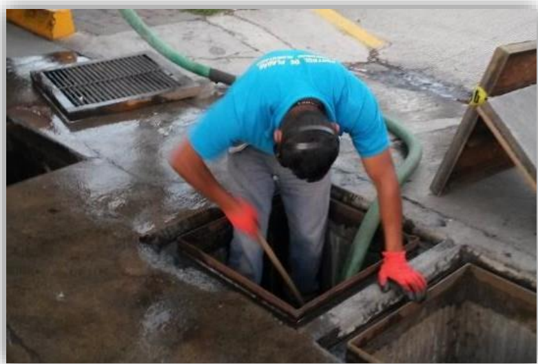
Limpieza y desinfección de cisternas
