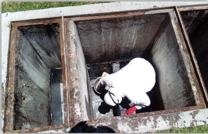
Limpieza y desinfección de trampas de grasa
