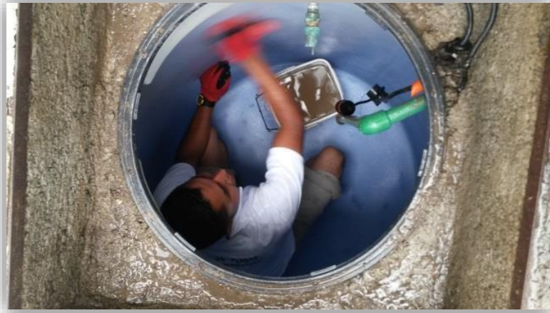
Limpieza y desinfección de tinacos
